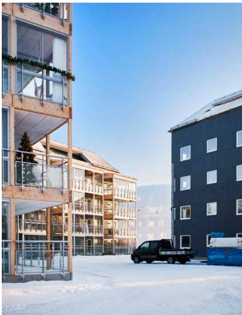
Grönbo, Södra Karlgård, Skellefteå. Bygge i fyra våningar plus taklägenheter.
