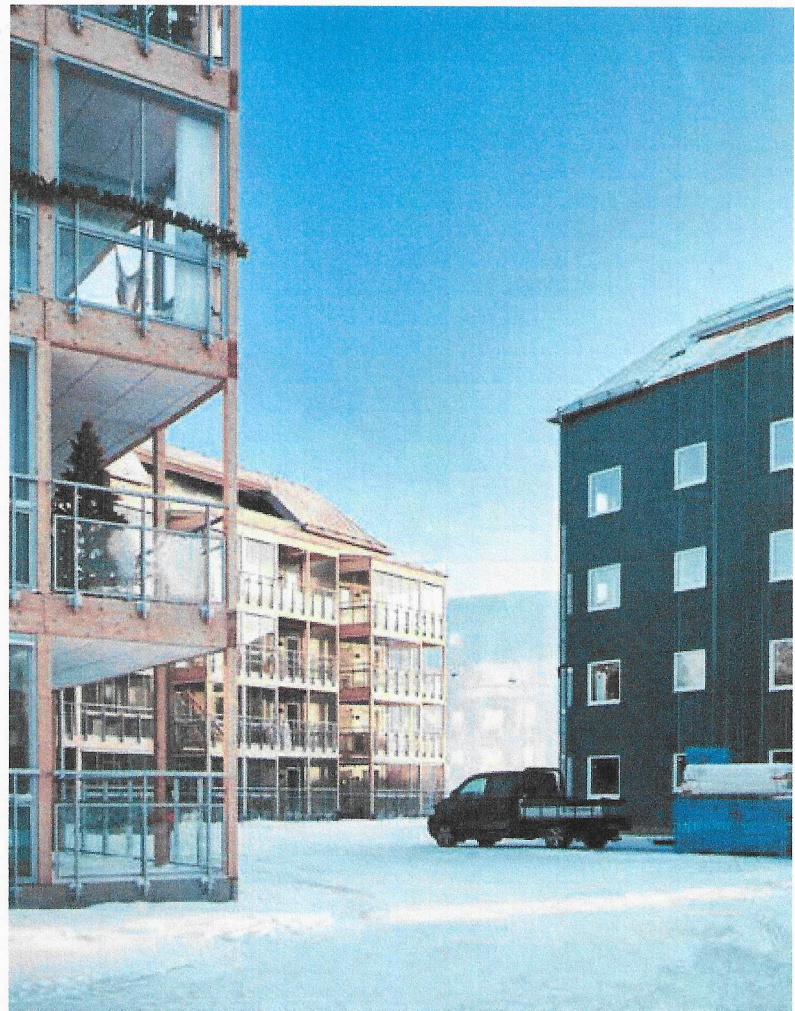
Grönbo, Södra Kartgård, Skellefteå. Bygge i fyra våningar plus taklägenheter.
